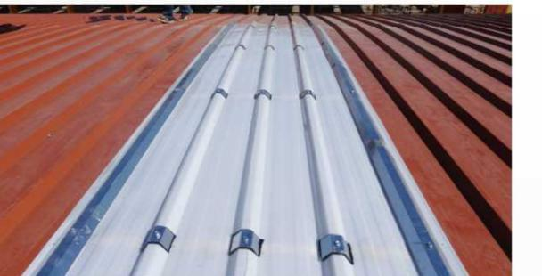
**فلاشینگ:** در هنگام همپوشانی ورق‌های موجدار با ورق‌های گالوانیزه و یا ساندویچ پانل‌ها لازم است محل همپوشانی توسط ورق فلزی (با همان گام) محکم شود. لازم به ذکر است استفاده از نوار لاستیکی میان فلاشینگ ضروری است.
